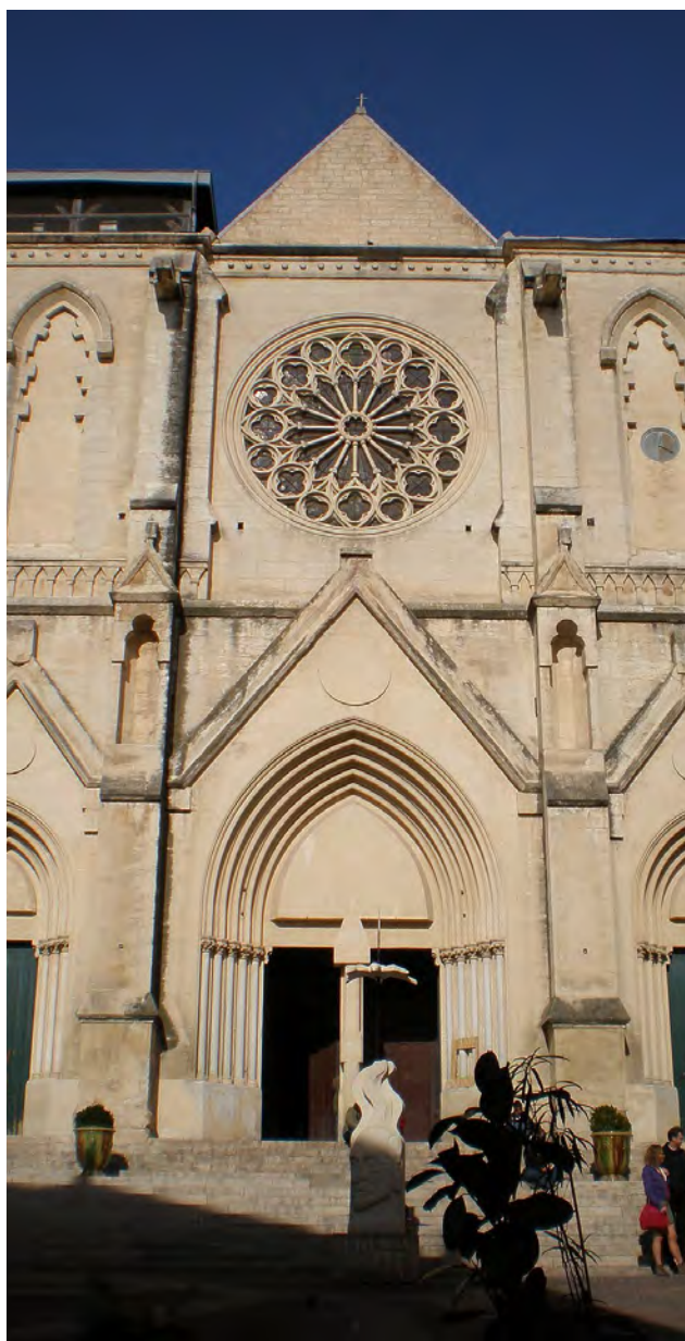
La facciata del Santuario di San Rocco a Montpellier
